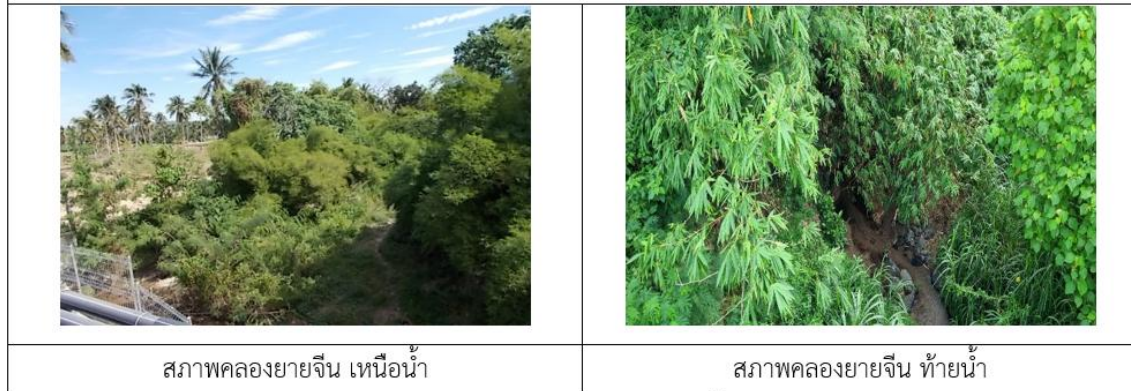
รูปที่ 5-14 สภาพคลองยายจิ้นบริเวณจุดตัดทางหลวงพิเศษระหว่างเมืองหมายเลข 7
