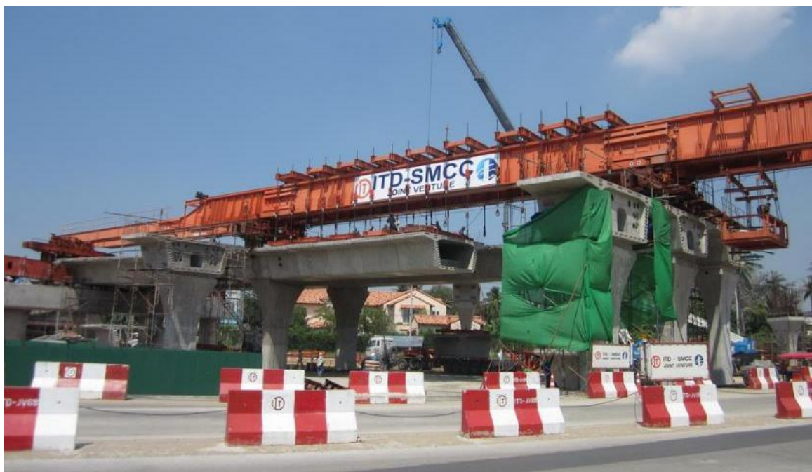
รูปที่ 5-9 โครงสร้างคานคอนกรีตอัดแรงรูปกล่องหล่อสำเร็จเป็นท่อน
